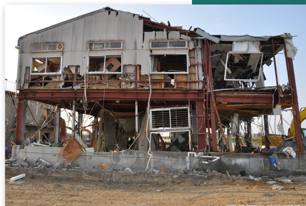
Los temblores del terremoto seguidos del tsunami dañaron tanto la armazón de acero como el armazón de acero de sujeción de este edificio.
